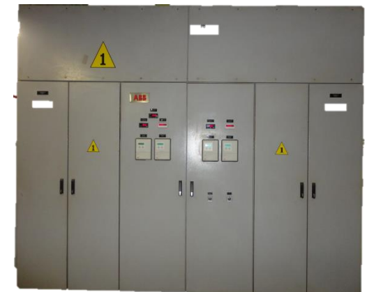
Paineis de Potencia existentes
